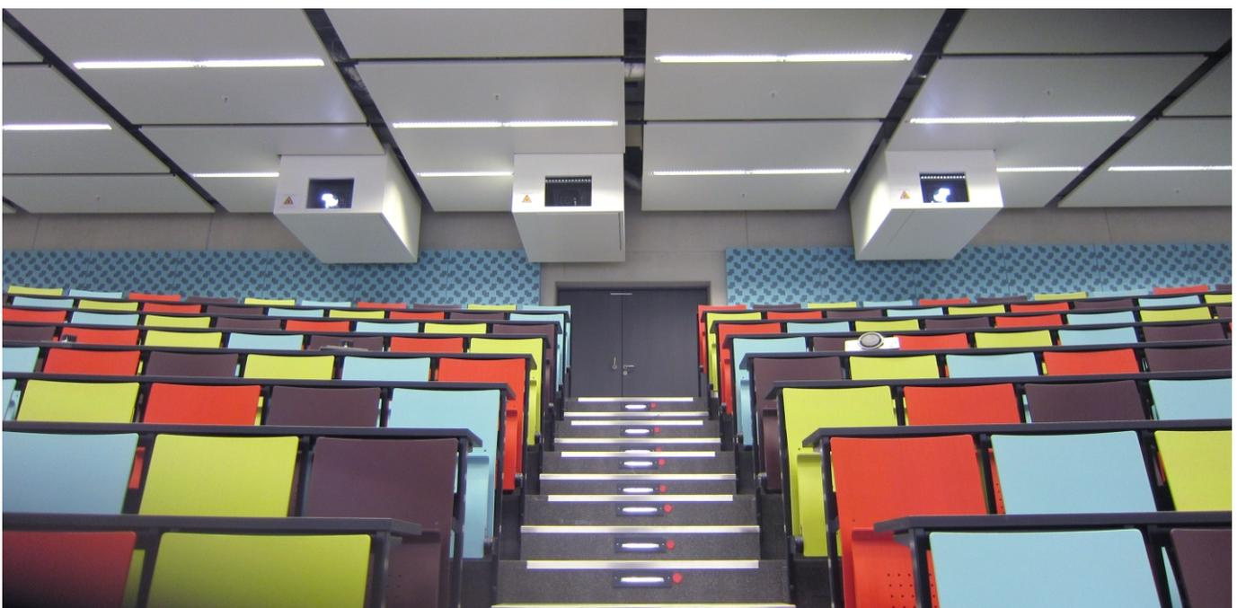
Für diese drei große Xenon Projektionen haben wir eine Sonderlösung entwickelt. Der Heißluftauslass des Gehäuses wurde an die bestehende Klimaanlage angekoppelt. Jedes Gehäuse hat einen integrierten Lift, damit ist die Wartung der einzelnen Projektoren extrem vereinfacht, da der Service in Tischhöhe erfolgen kann.
